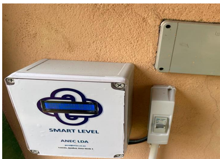
Painel principal com display para apresentação dos dados da leitura
